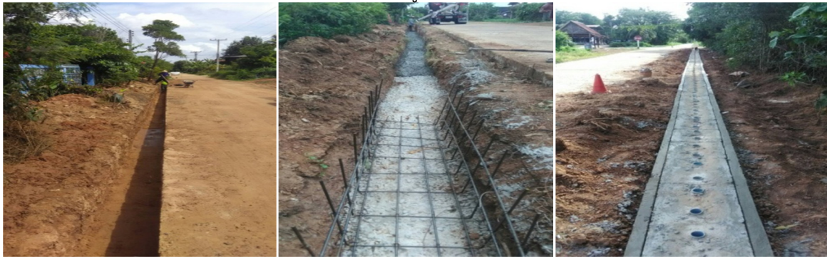
วางระบายน้ำคอนกรีตเสริมเหล็กหมู่ที่ ๑๐
